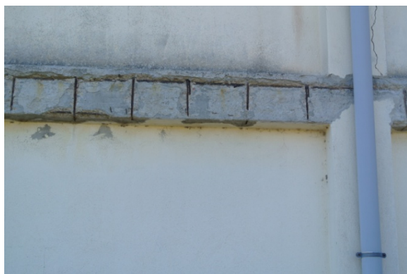
Figura 16 – cls ammalorato edificio lato nord
