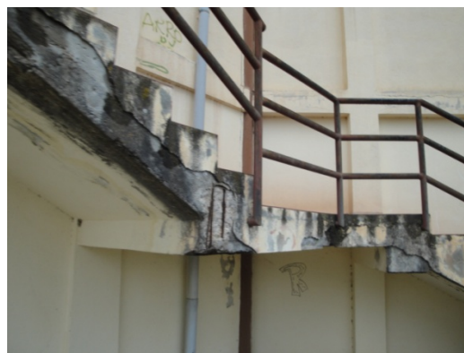
Figura 17 – cls ammalorato scala lato est
