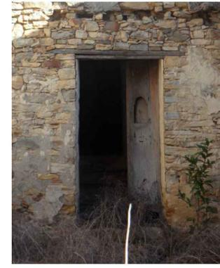
porta con architrave di ridotto spessore e telaio fisso di irrigidimento
