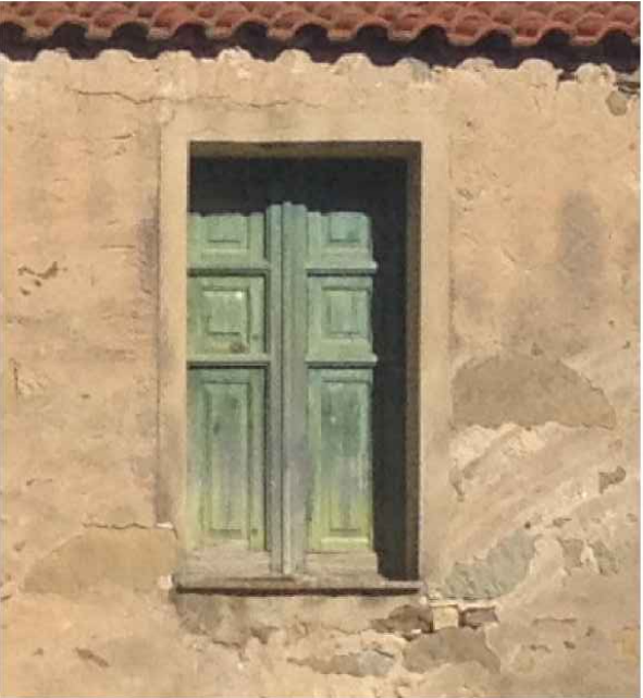
finestra senza stipiti con architravi lignei con cornice in intonaco in risalto; il serramento vetrato è a due ante protetto da scurini interni
