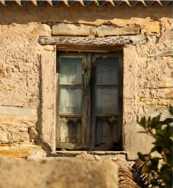
finestra senza stipiti con architrave ligneo squadrato sovrastato da elemento di scarico in pietra con cornice intonacata in risalto
