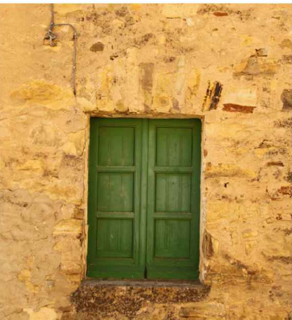
finestra senza stipiti con piattabanda di altezza variabile in conci lapidei allungati disposti secondo i raggi di un arco
