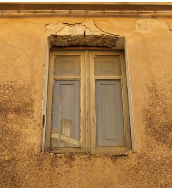
finestra senza stipiti con piattabanda di altezza costante in conci lapidei squadrate allungati disposti secondo i raggi di un arco
