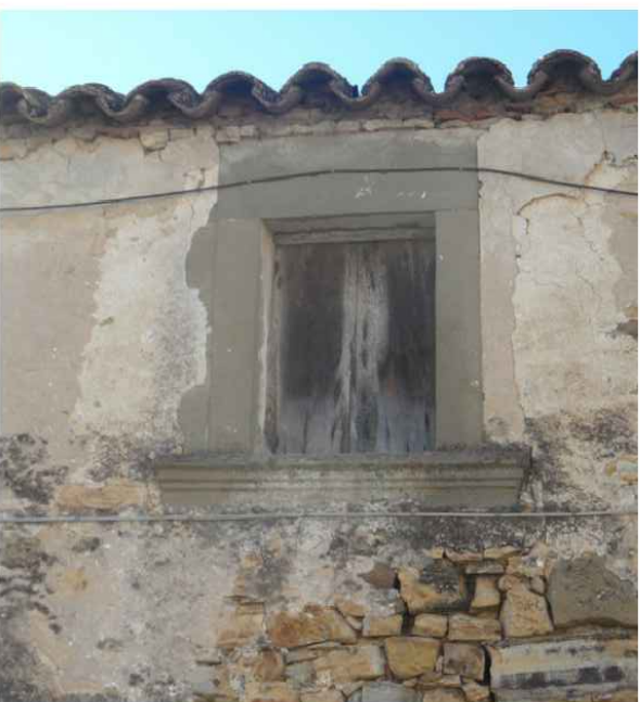
finestra con cornice lapidea sui quattro lati in pietra squadrata con davanzale modanato in risalto e architrave a parte degli stipiti in risalto a vista
