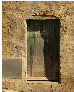
porta senza stipiti con architrave a vista sbazzato, senza telaio fisso con serramento di recupero
