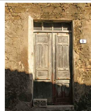
porta vetrata a due ante con architrave in cls di sostituzione dotata di sopralluce e scurini esterni
