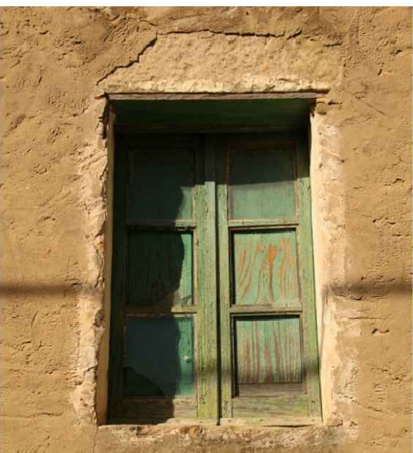
finestra con architrave lapideo che sovrasta una tavola di regolarizzazione, con serramento a due ante vetrate e scurini interni
