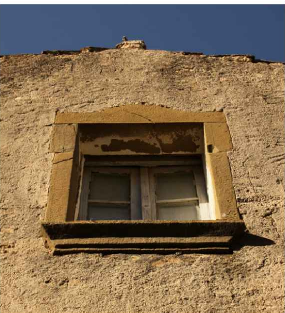
finestra con cornice lapidea sui quattro lati in pietra squadrata con davanzale modanato in risalto e architrave a sezione variabile
