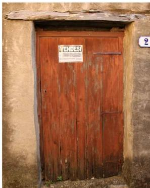
porta senza stipiti con architrave a vista sbazzato, telaio fisso su tre lati e serramento con bandelle
