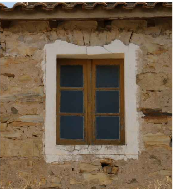
finestra senza stipiti con piattabanda di altezza costante in conci lapidei allungati, con serramento vetrato a due ante
