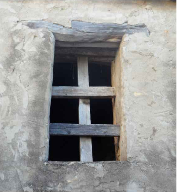
finestra senza stipiti con architravi lignei sbozzati giustapposti senza serramento con grata di protezione in legno
