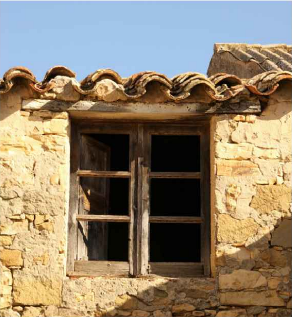
finestra senza stipiti con architrave lignea squadrata di lieve spessore; il serramento è a due ante vetrate protetto da scurini interni
