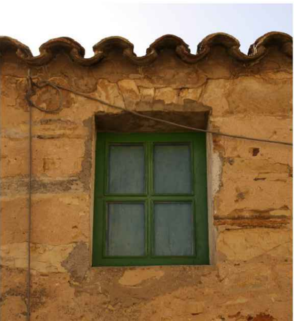
finestra senza stipiti con piattabanda di altezza costante in conci lapidei allungati paralleli, disposti in due file a contrasto tramite concio di chiave
